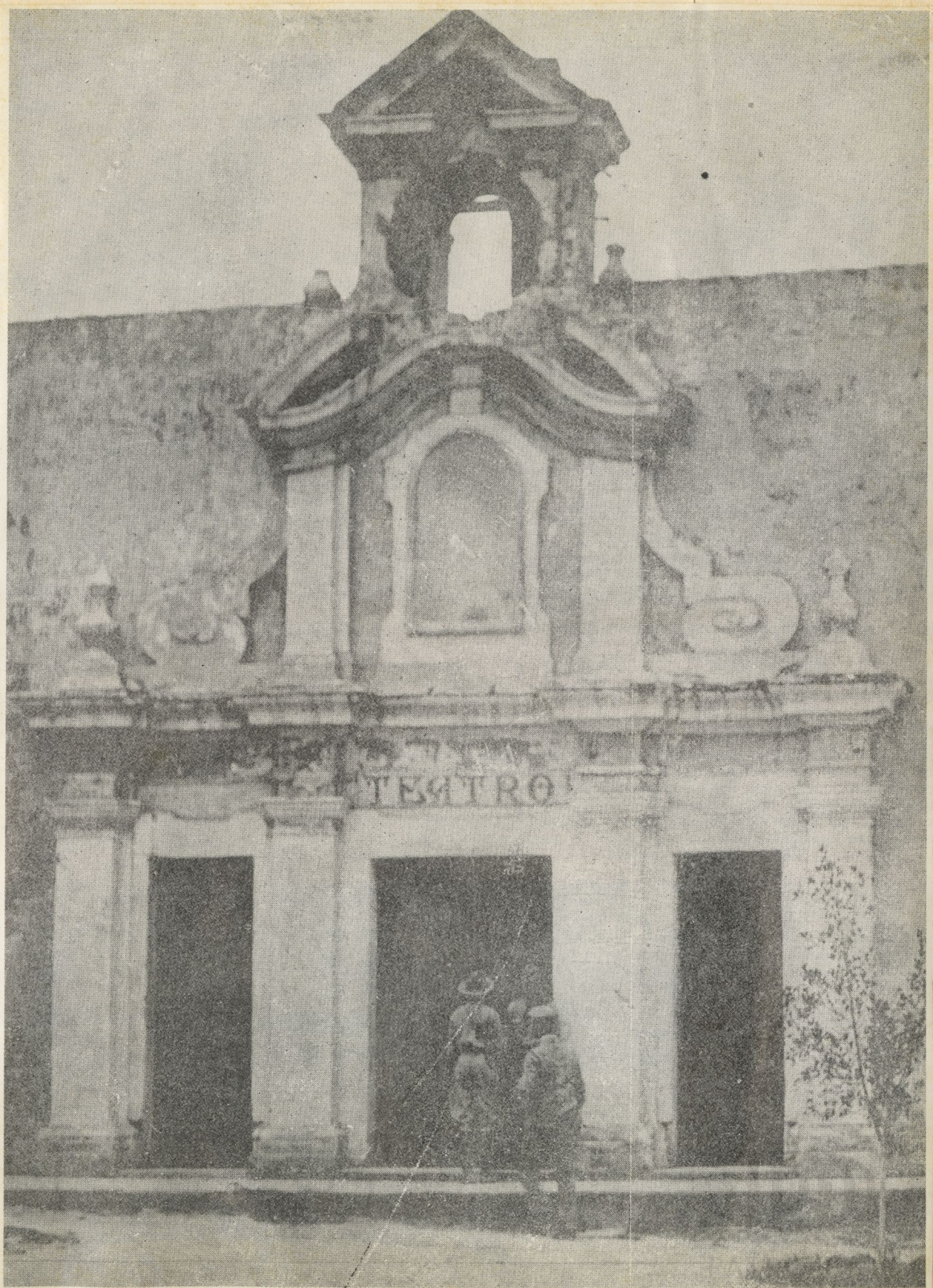
Fortaleza de la Cabaña. Fachada de la antigua capilla dedicada después a Teatro y posteriormente a Sala de Consejos del Tribunal Militar, ejecutada por el Arquitecto Pedro Medina. Véanse las similitudes que hay entre sus nichos, aletones, cõpas y pináculos, con otros elementos de la Catedral.
