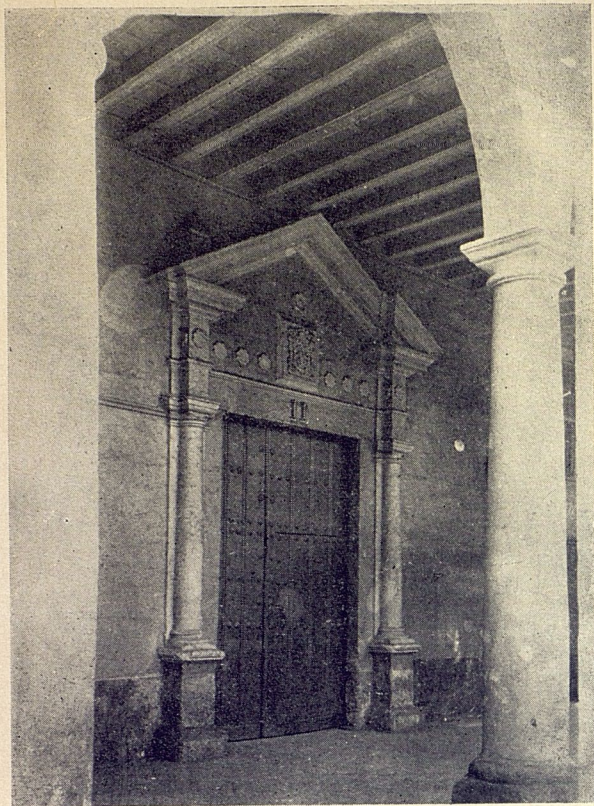
Puerta principal de la casa Muralla 11 esquina a San Ignacio.
