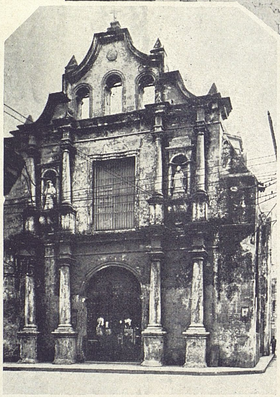
Fachada principal de la iglesia de San Francisco de Paula, que se encuentra en deplorable estado de ruina
