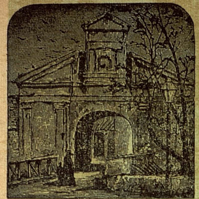
La Puerta de Tierra, una de las que se abrían en las viejas murallas, a la que daba acceso la calle Muralla.
