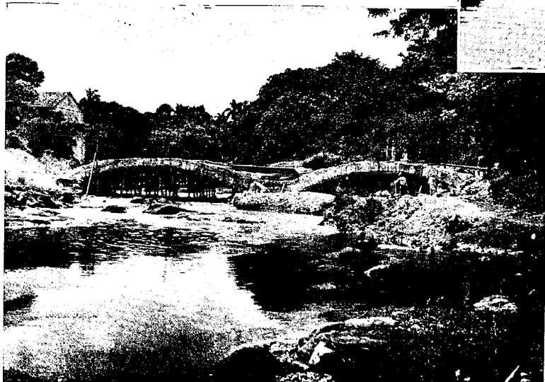
Puente rústico sobre el río Almendares para cruce de peatones y automóviles.
