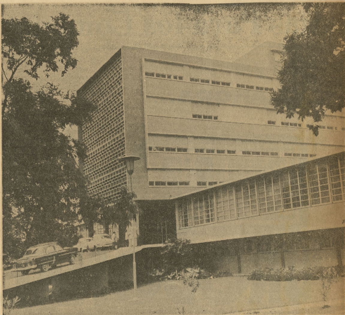
VISTA PARCIAL DEL bloque de entrada del Hospital Municipal Clínico Quirúrgico "M" con su rampa para automóviles, que acaba de ser concluido y será inauarado el próximo corrientes. Esta obra consta de sótano, basamento, principal o típica, cuatro pisos superiores. Permitirá un alojamiento de 300 enfermos.
