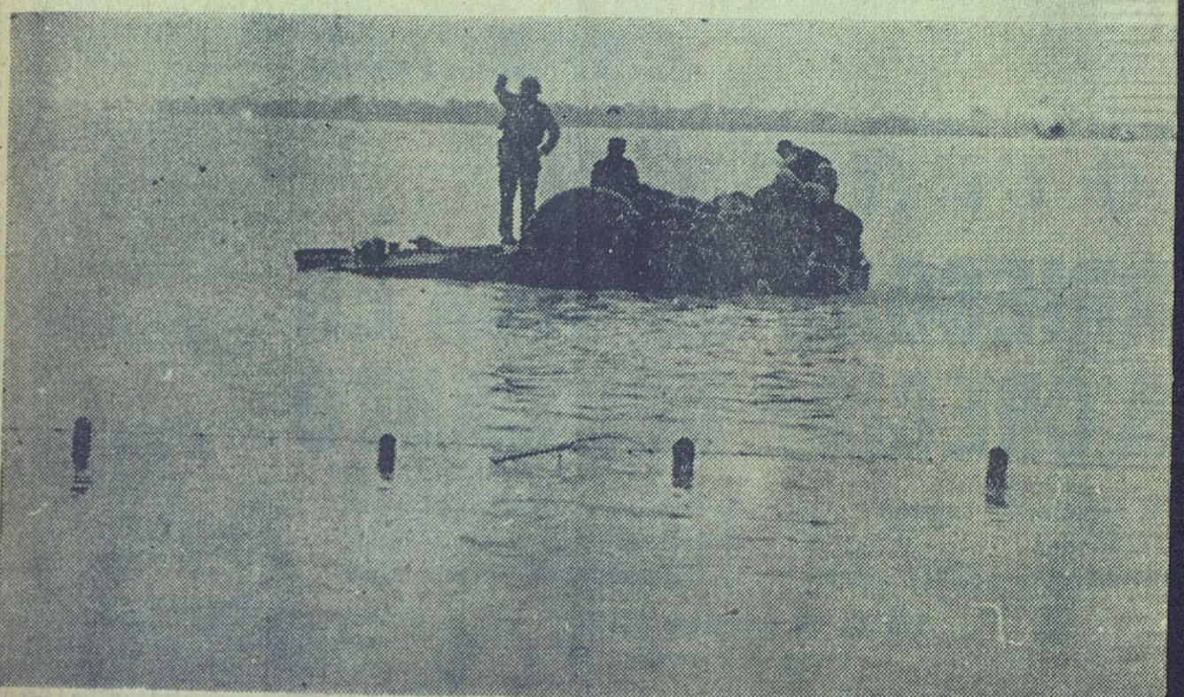
Ya el anfibio donde va Fidel se ha adentrado en la crecida del Cauto. Desde allí, continúa impartiendo instrucciones a los que quedaban en terreno firme.
