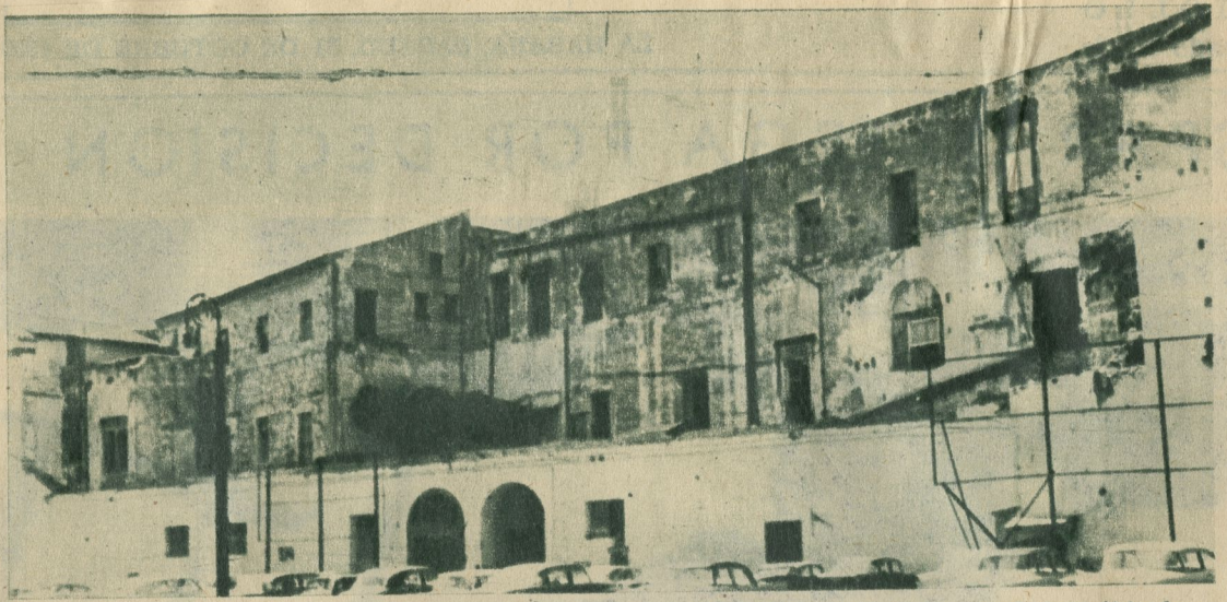
...fachada posteriores del convento de San Francisco después que fué demolida la espaciosa nave anexa fabricada a comienzos de este siglo para dependencia de correos.
