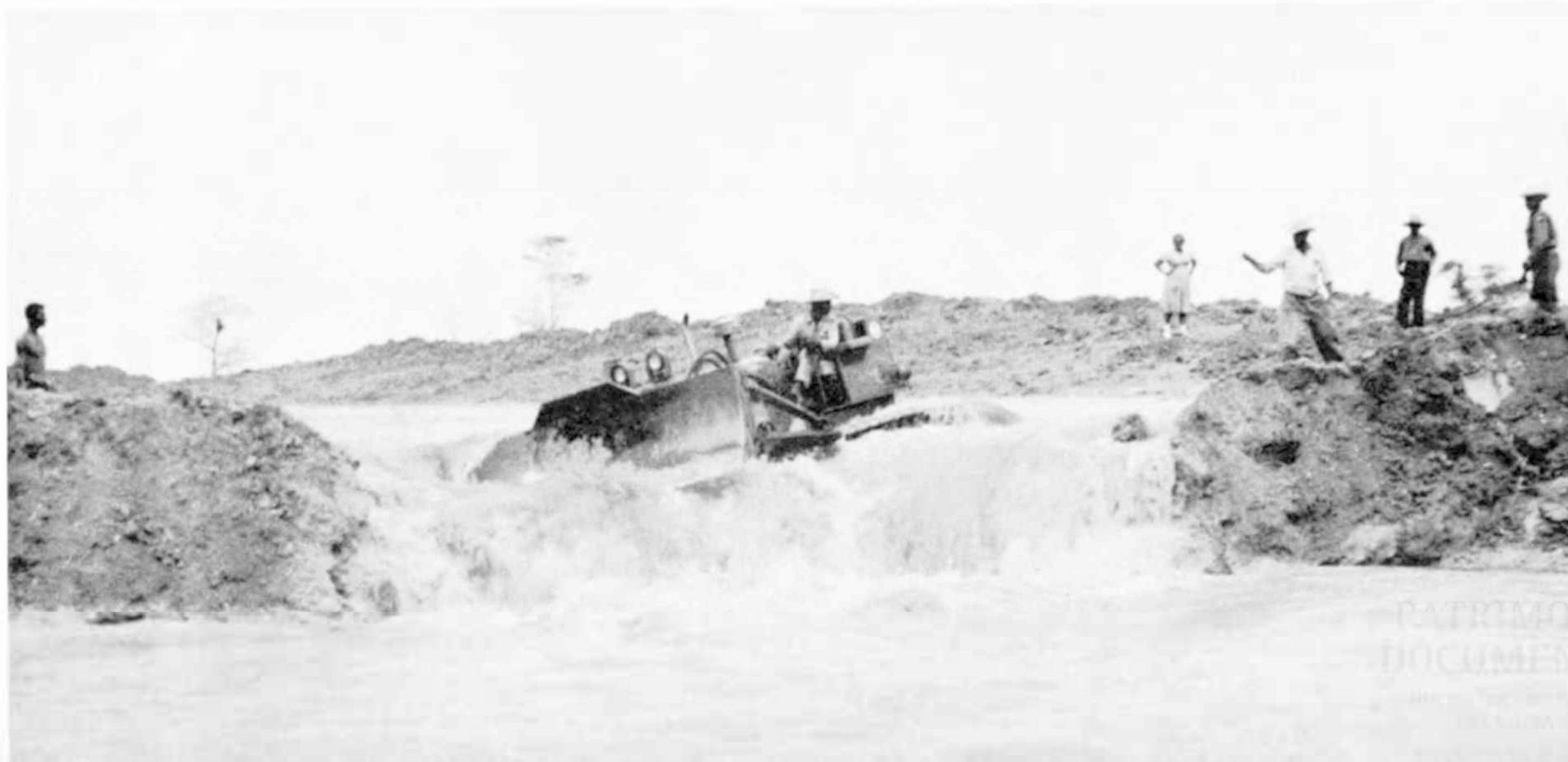
TRACTORES EN LA LABOR DEL CANAL CONDUCTOR DE LAS AGUAS DE LOS RIOS SALADO Y CAUTO AL TERRENO
