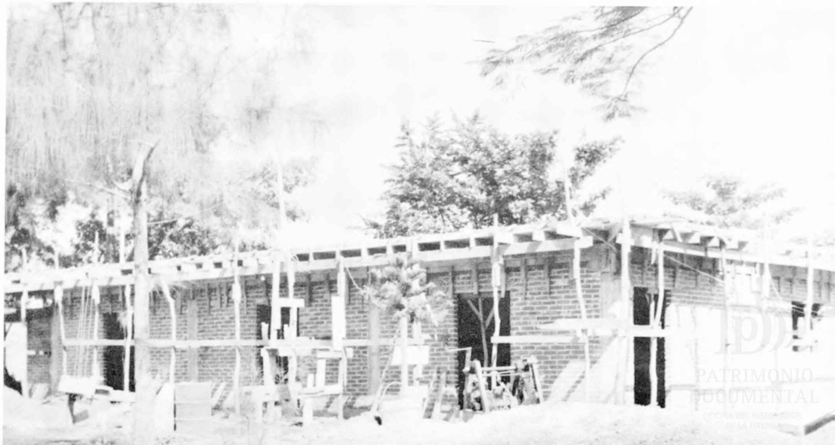
DEPARTAMENTO COMERCIAL, TIENDA DEL PUEBLO EN CONSTRUCCION
