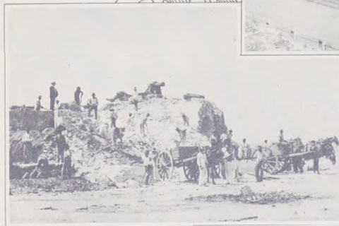
Obreros demoliendo la "bateria", durante la administración militar norteamericana.
