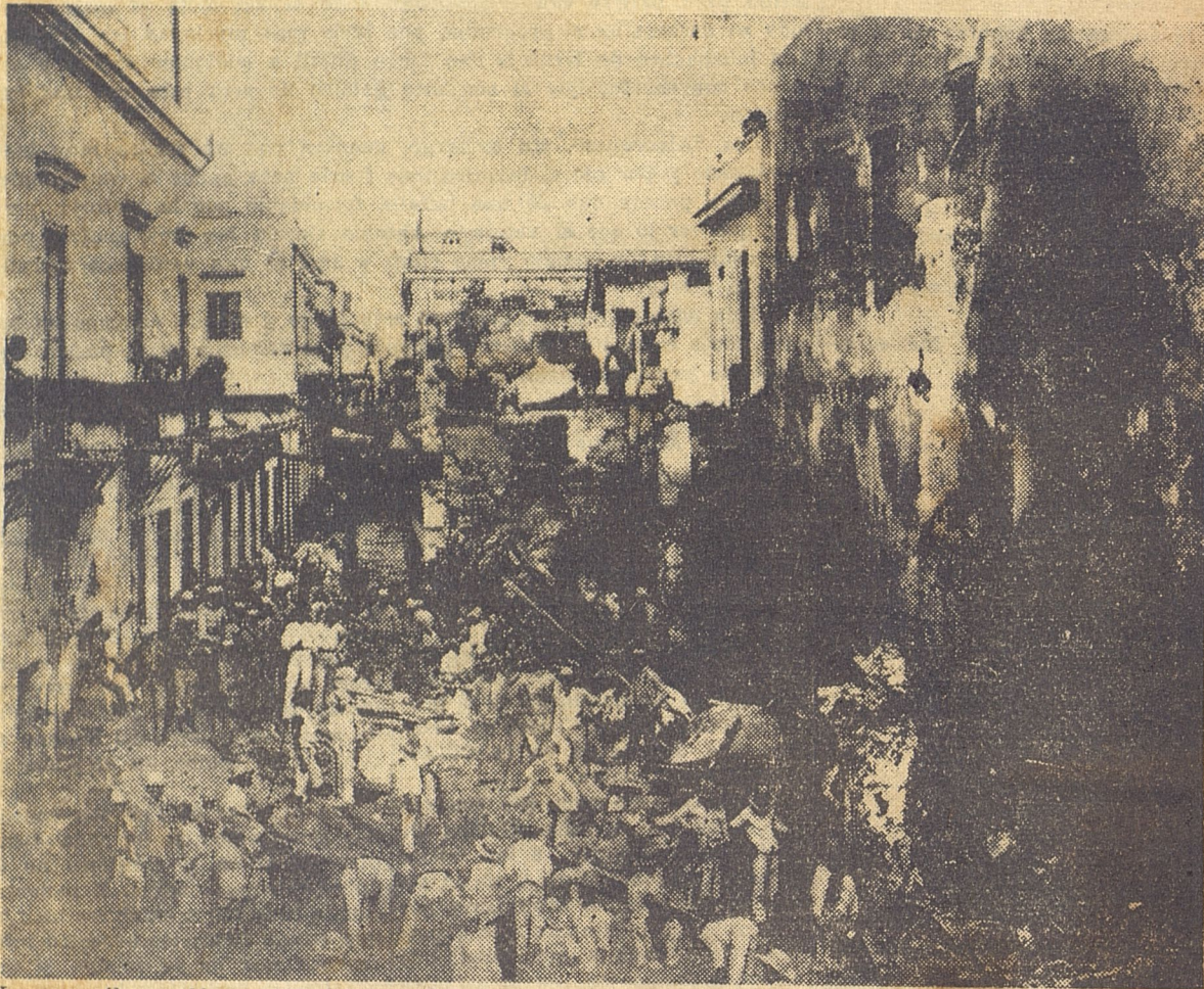
Lo que sólo quedó en 1895 del famoso taller de Estanillo. Cuadrillas de obreros escombren el lugar, mientras en uno de los extremos de la calzada del Monte, próximo a la calle de Matadero, se ha situado un grupo de voluntarios españoles. Al fondo, sobre la única parte del edificio que no fué destruída, el alcalde español mostrando su bastón y un escribano, que hacía apuntes de los destrozos causados.
