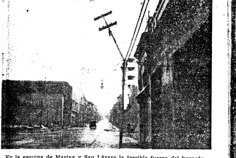
En la esquina de Marina y San Lázaro la terrible fuerza del huracán partió en dos un poste del alumbrado eléctrico. La parte superior permanece sujeta a los cables.
