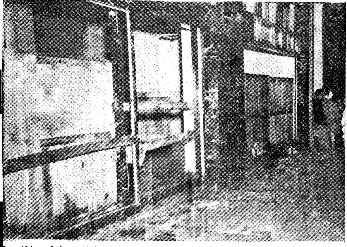
Las vidrieras de la mueblería situada en Galiano, entre Virtudes y Animas fueron destrozadas cuando una ventana, arrancada de un quinto piso de un edificio situado enfrente, fué a chocar contra sus cristales, invalidando todas las precauciones tomadas por los propietarios del comercio.
