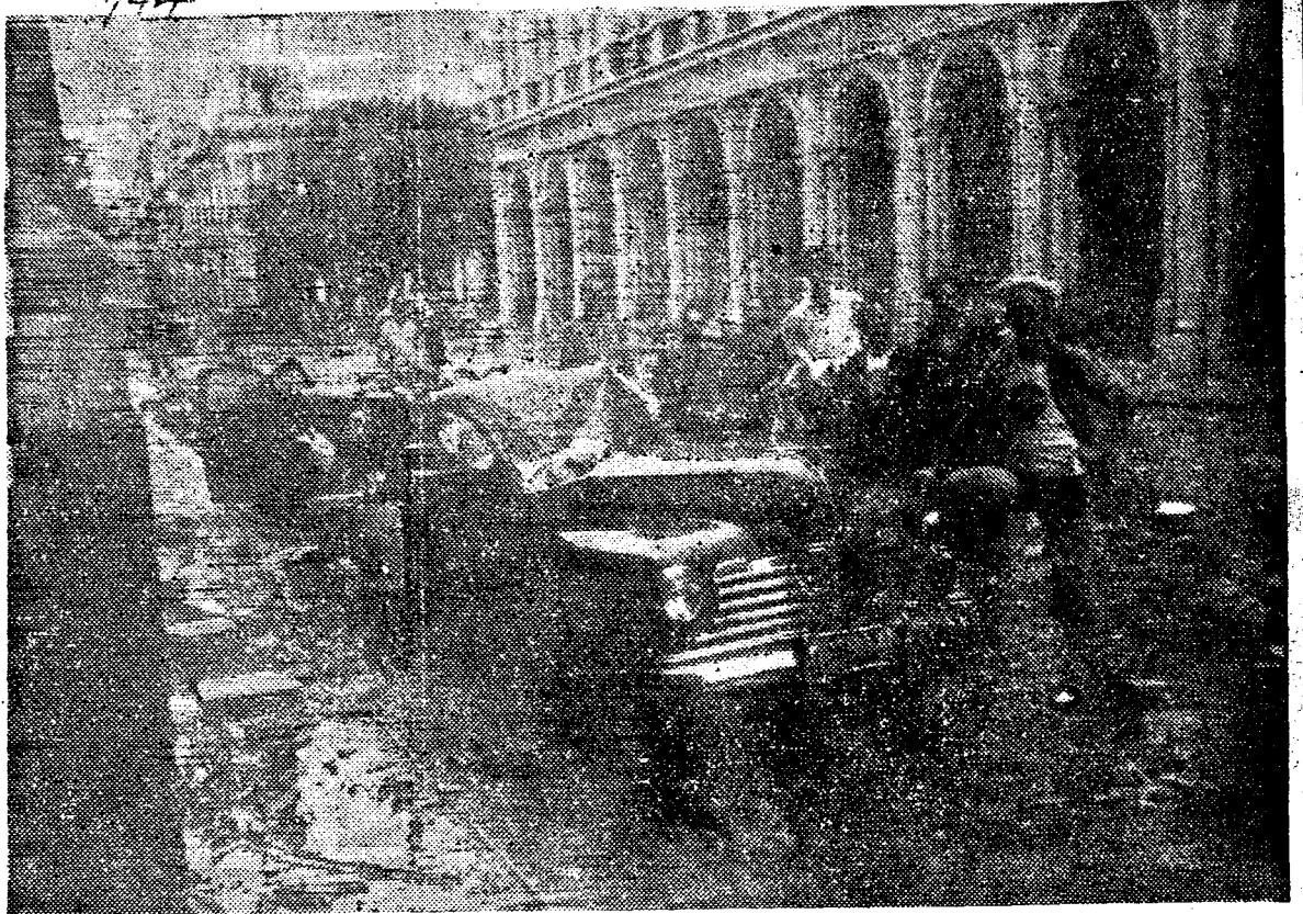
Sobre dos bellos autos, parqueados en Trocadero entre Prado y Zulueta, cayeron los escombros de un balcón y una cornisa arrancados por el huracán, hundiéndoles totalmente el capó.
