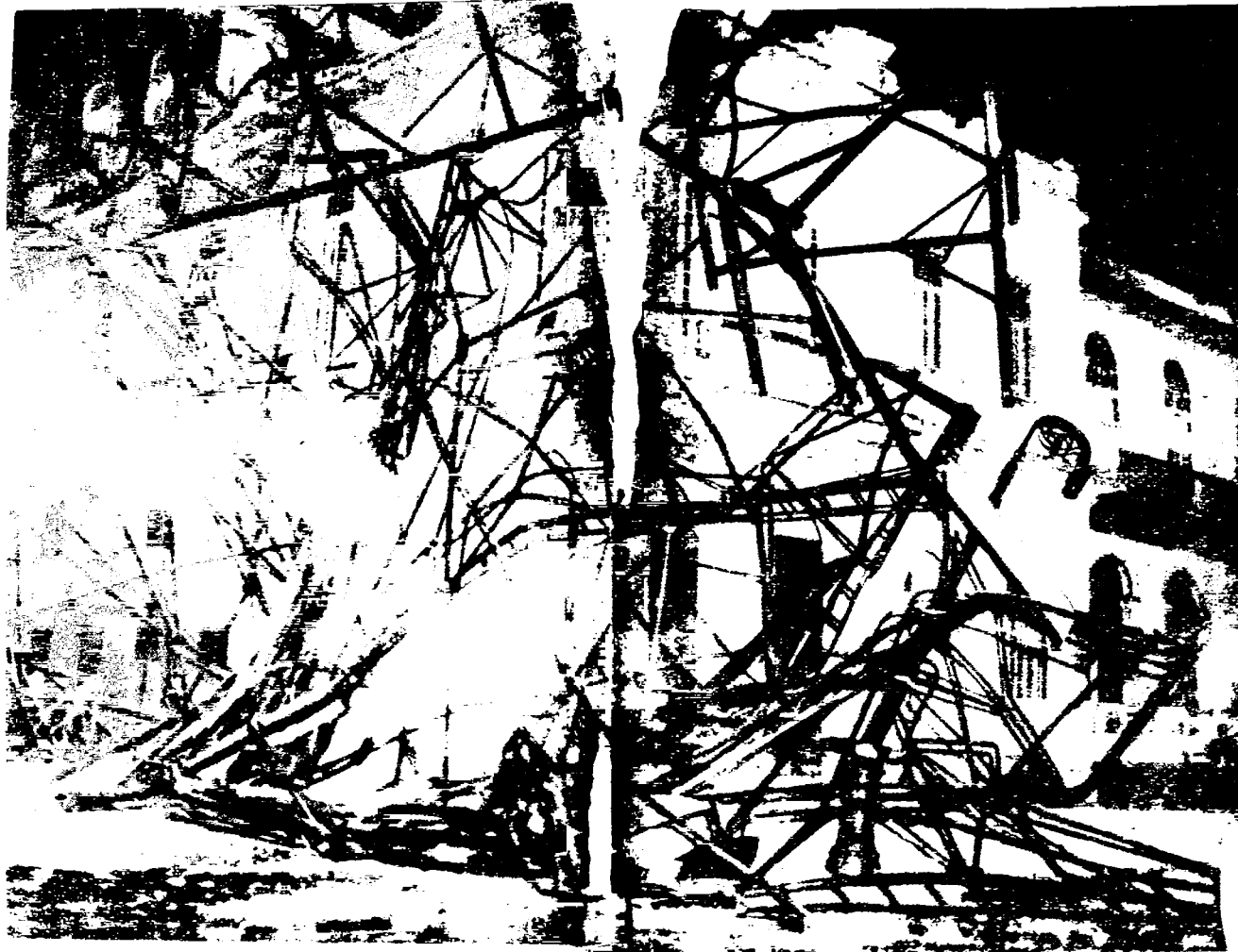
El ciclón que azotó La Habana en 1948 no causó grandes daños. Fue de moderada intensidad. Este anuncio luminico en el Malecón se derrumbó aparatosamente sin causar víctimas.
