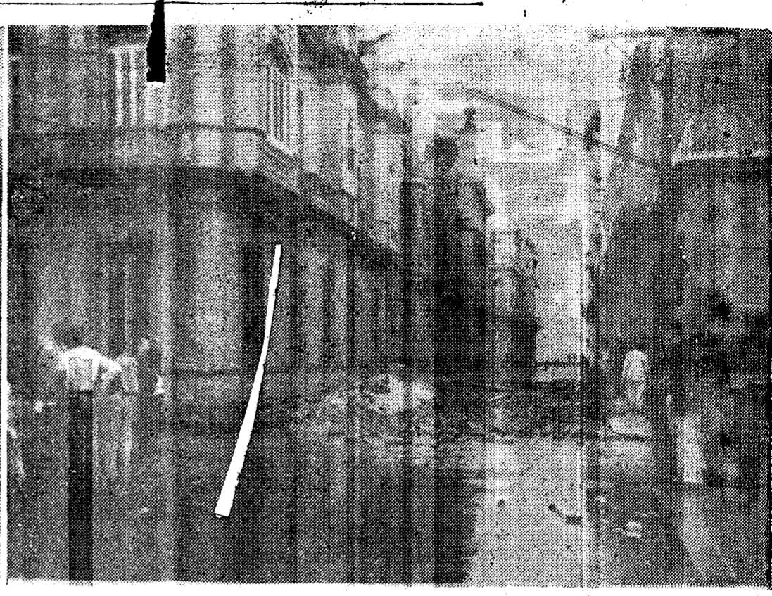
La Casa del Artista, en Lagunas y Perseverancia, sufrió grandes desperfectos. El último piso se derrumbó causando los escombros en su caída graves daños a las casas colindantes.
