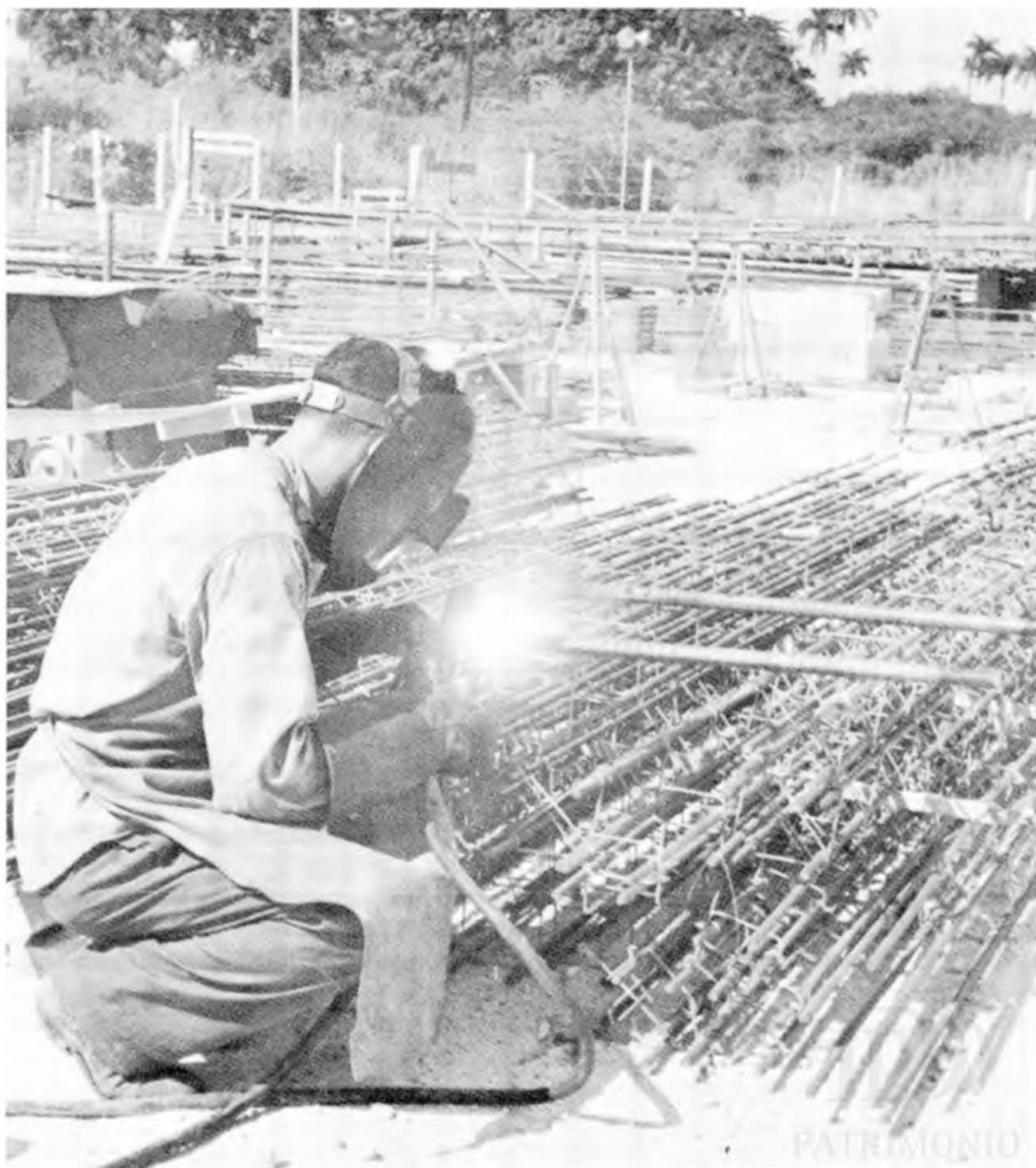
Invariablymente todo el encabillado se suelda previamente para evitar surja cualquier falla.
