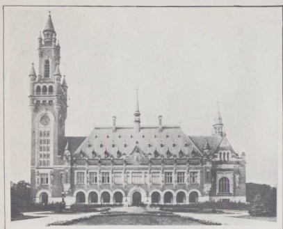
Palacio de la Paz de El Haya. Fachada principal.
