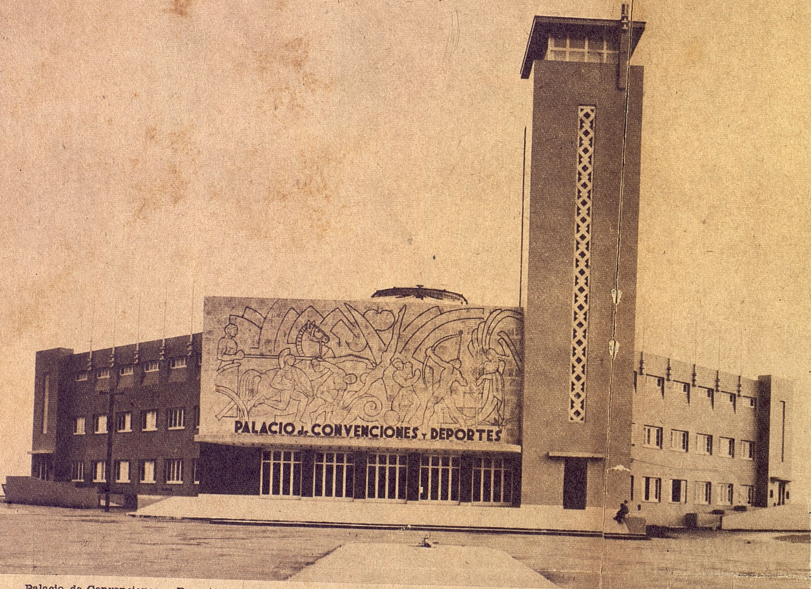
Palacio de Convenciones y Deportes, diseñado y construido por el ingeniero José Pérez Benitoa, con magníficos resultados, y resolviendo múltiples problemas de competencias y exhibiciones, edificio que ocupa el centro de la composición urbanística concebida por dicho ingeniero.
