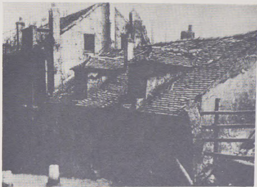
La casa de Mimí Pinsón, en el número 18 de la calle Mont-Cenis, tal como hoy se encuentra, y cuya demolición se ha comentado últimamente en la prensa parisienne. (Foto Vidal).
