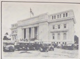
Fachada principal del nuevo Palacio de Justicia que acaba de inaugurarse en la ciudad de Santa Clara, de nuestra República. (Foto O. P.)
