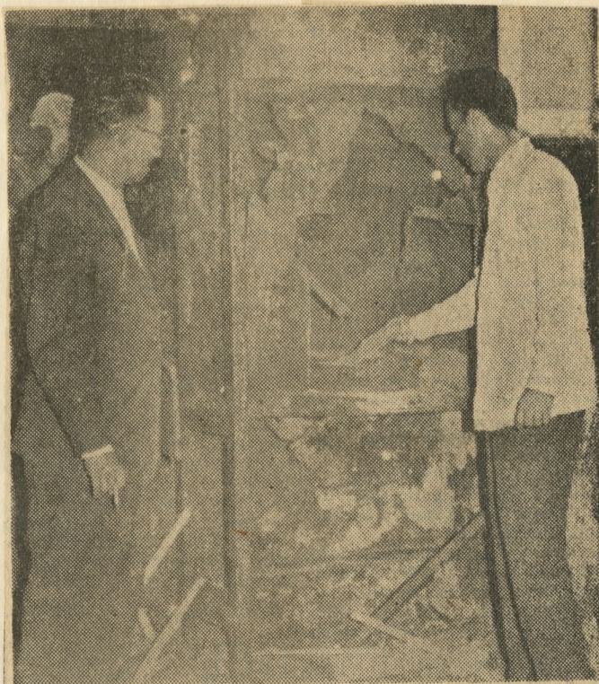
...ante el horno antiquísimo de la cocina del convento de Santa Clara de Asís hablan el encargado de las obras que allí se realizan, señor Oswaldo Relova y nuestro compañero Octavio de la Suarée. Obsérvese en la foto el zuncho de un caldero colonial.
