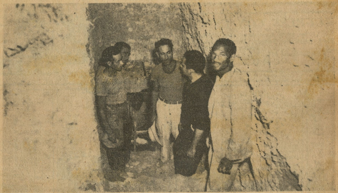
Leopoldo Cañete y Epifanio Vázquez, al fondo, explican al repórter Alfredo Núñez Pascual cómo descubrieron la entrada de los subterráneos cuando excavaban para los cimientos del edificio que se construye con destino al Hospital de la Liga Contra el Cáncer.
