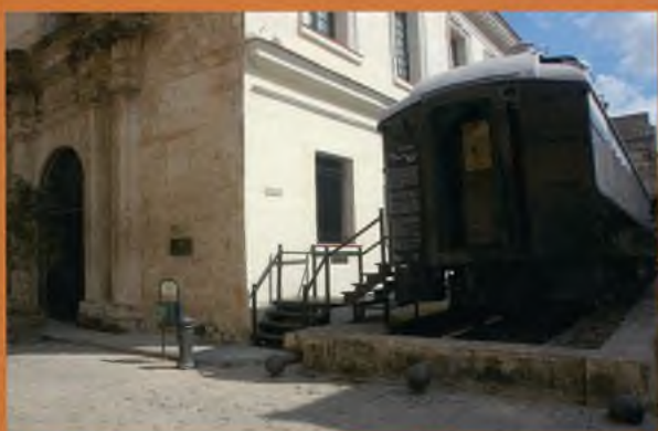
Foto 2: Vista esquinada de la Capilla de la Orden Tercera en la intersección de las calles Oficios y Churruca. Este último callejón ocupa la parte del terreno que perdió el convento y lo separa hoy de la antigua Cámara de Representantes (1911), actual sede del Gobierno Municipal de la Habana Vieja. En primer plano, el famoso vagón presidencial Mambi.
