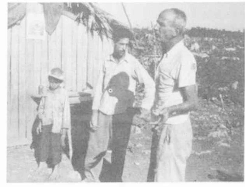
En la construcción del Centro Comunal de Guanahacabibes se emplean obreros de la región, bajo la orientación técnica del ingeniero Betancourt. Será una obra más del INRA.
