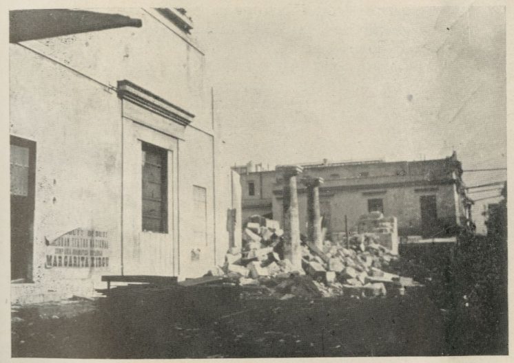
Columnas que sostenían el techo del atrio de la iglesia en su fachada por la calle de O'Reilly.
