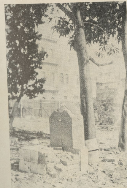
Uno de los grifos que surtían de agua al Monasterio.
