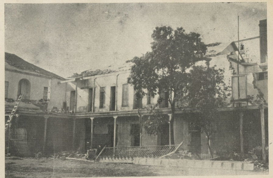
Esta foto fué tomada al iniciarse los trabajos de demolición y nos muestra una de las galerías de planta alta, al ser desprovista de las tejas que formaban su techo.
