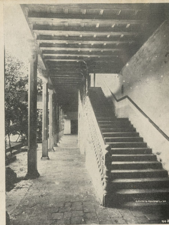
Escalera que daba acceso a las galerías superiores del Monasterio.
