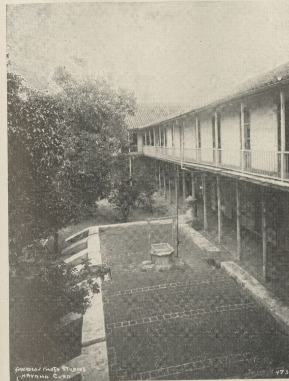
Vista de uno de los patios, mostrando el algibe donde se recogían las aguas de lluvia para el uso del Monasterio.
