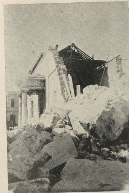
La nave principal de la iglesia cuando estaba casi demolida.
