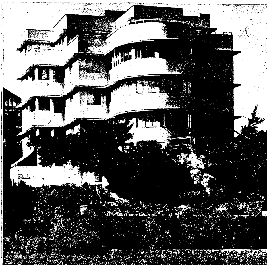
Elegantemente aprovechados todos los bellos y confortables recursos del modernismo en la Arquitectura, de RAFAEL DE CARDENAS, su proyectista y constructor, mostramos este edificio de apartamentos situado en Ave. del Río, Alturas de Miramar.
