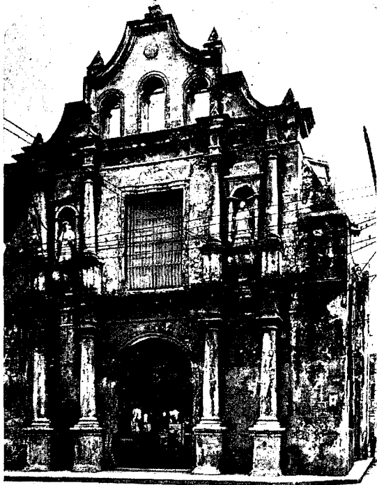
Fachada principal de la iglesia de San Francisco de Paula, que se encuentra en deplorable estado de ruina
