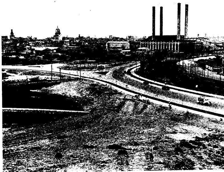
Paso Superior construido en la barriada de Luyanó.
