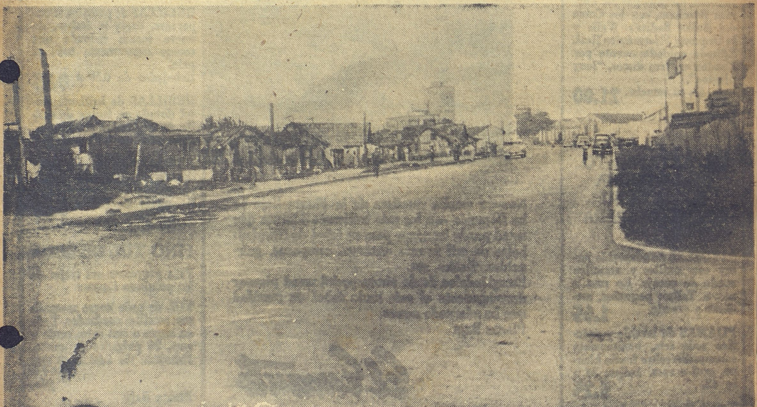
La fotografía da una visión de conjunto de la avenida Gancedo que va de Concha a Fábrica. A la izquierda, tomando hasta la acera de la céntrica rúa, el barrio «Isla de Pinos», representa la mancha de ignominia más vergonzante de cuantas afean a la urbe, la contaminan de los más rancios olores, la amenazan de las peores epidemias y la degradan.
