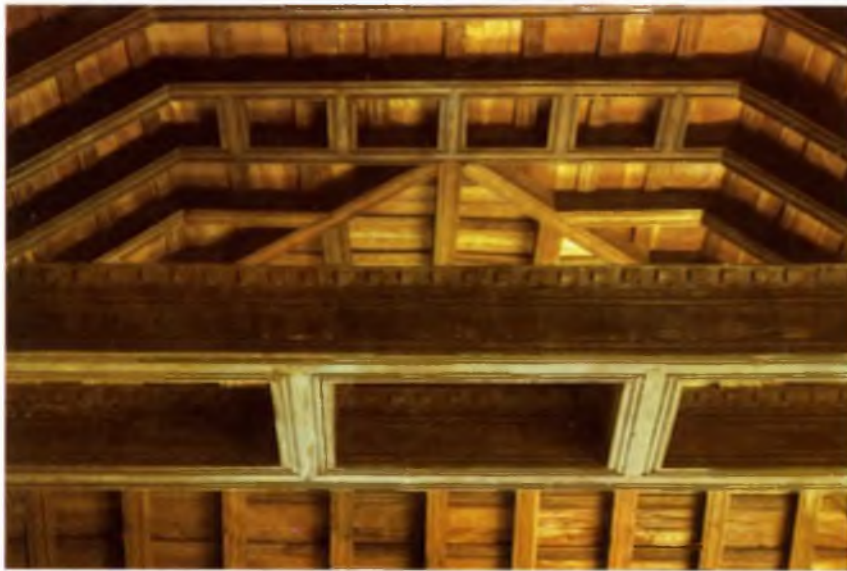
La secuencia de nudillos y su entablado se conoce como harnervuelo o almizate. La cubierta toma así forma de artesa y propicia decoraciones con lacerias o figuras geométricas.
