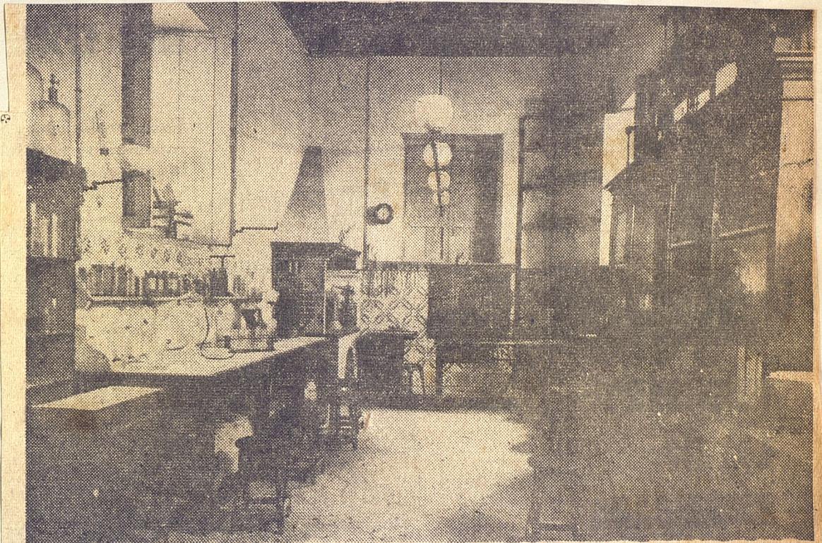
Cocina del edificio de la Diputación, adaptada para el Laboratorio Químico de la Escuela de Artes y Oficios. Esta foto fué tomada por el profesor de la Escuela e ilustre médico, doctor Cándido Hoyos.
