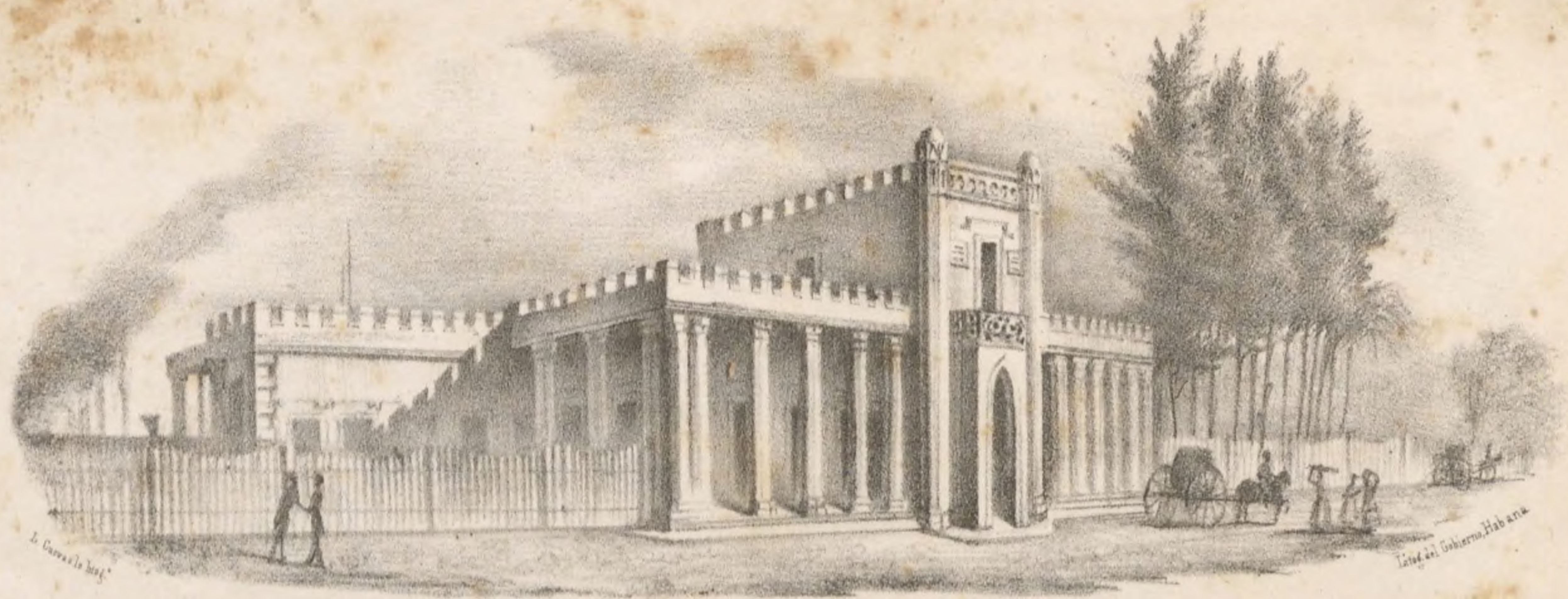
CASA DE PARADA EN EL SITIO DE LOS ALMACENES DEL CAMINO DE HIERRO.
