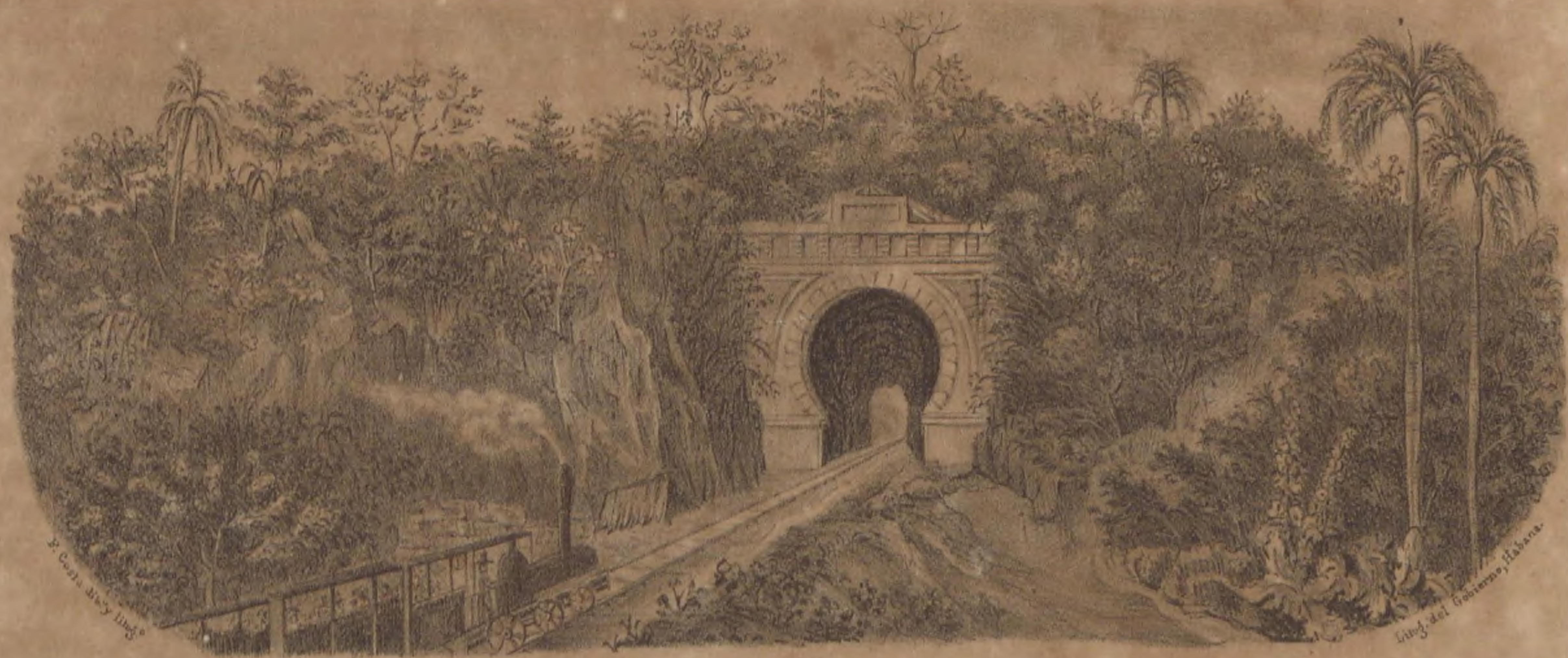
ARCO MORISCO A LA ENTRADA DEL SOCAVON.
