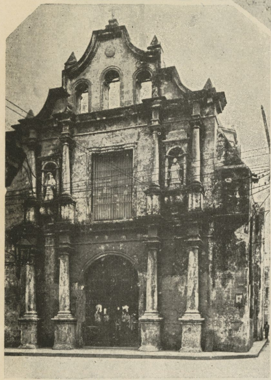
Fachada principal de la Iglesia de Paula, tal cual se encuentra en la actualidad.
