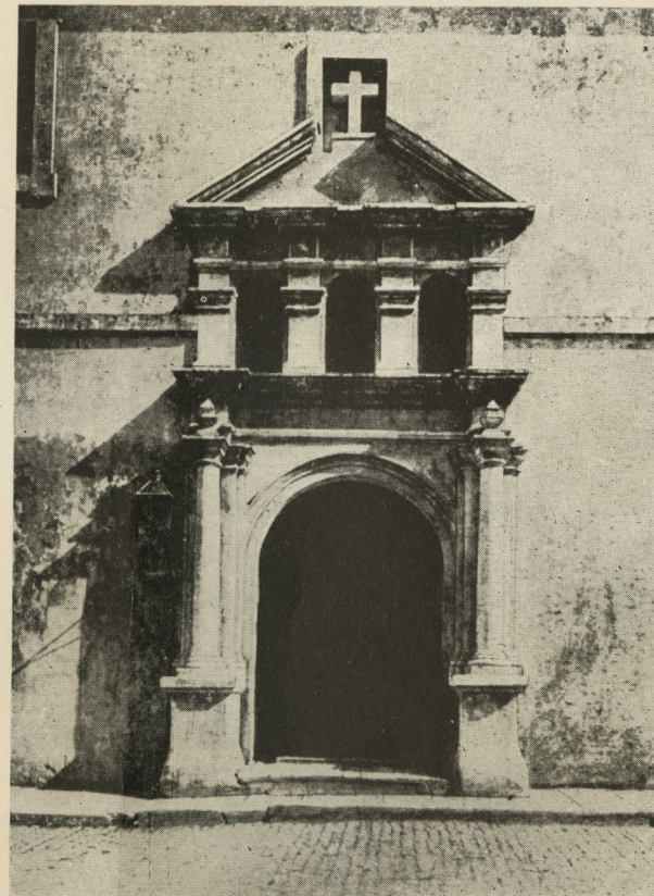
Entrada principal del viejo Hospital de San Francisco de Paula, ya demolida.
