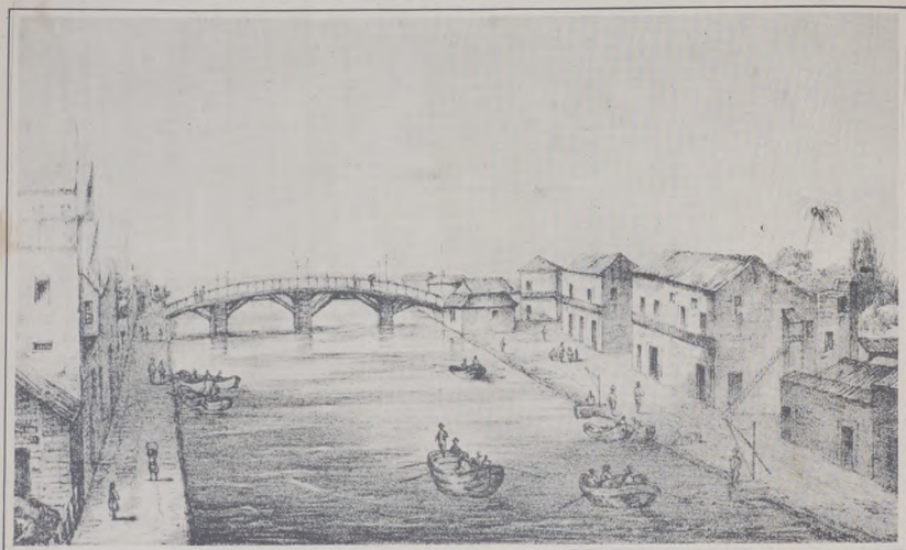
Puente sobre el San Juan y entrada a Pueblo Nuevo.
