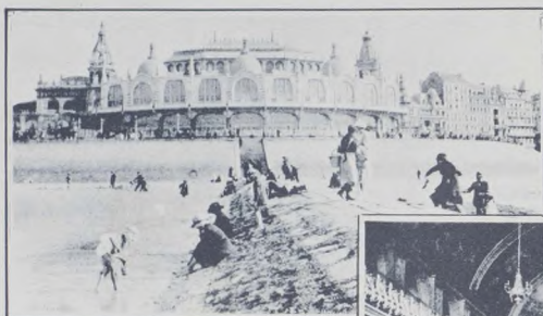
La fachada principal del famoso Kursaal de Ostende.
