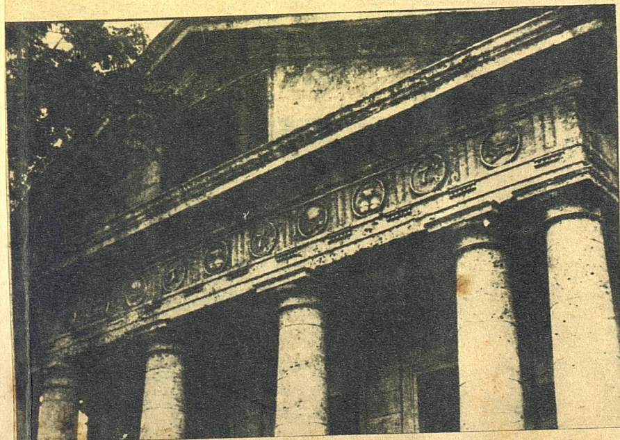
Del poco cuidado que se puso en la ejecución del Templete es buena prueba este entablamiento donde los motivos ornamentales se repiten y alternan caprichosamente...
