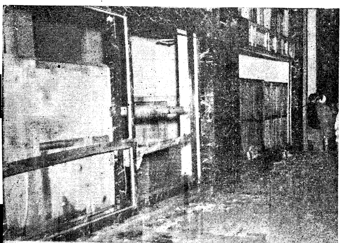
Las vidrieras de la mueblería situada en Galiano, entre Virtudes y Animas fueron destruidas cuando una ventana, arrancada de un quinto piso de un edificio situado enfrente, fué a chocar contra sus cristales, invalidando todas las precauciones tomadas por los propietarios del comercio.
