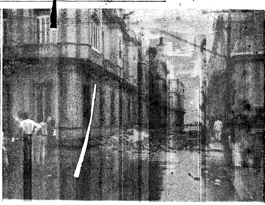
La Casa del Artista, en Lagunas y Perseverancia, sufrió grandes desperfectos. El último piso se derrumbó causando los escombros en su caída graves daños a las casas colindantes.
