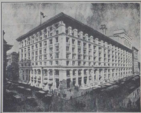
EDIFICIO PROPIO QUE OCUPA UNA MANZANA ENTERA
