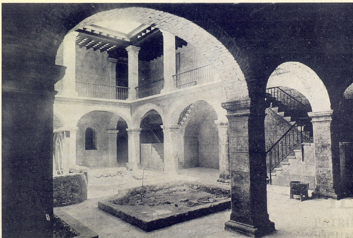
CASA DEL CONDE DE CASA BAYONA. ANGULO DEL PATIO.
