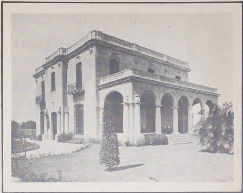
LUJOSA RESIDENCIA DEL SR. HENRY SENIOR - REPARTO MIRAMAR - Arquitecto y Contratista SR. ERNESTO BATISTA Directores Facultativos SRES. MORALES Y COMPAÑIA (Arquitectos)
