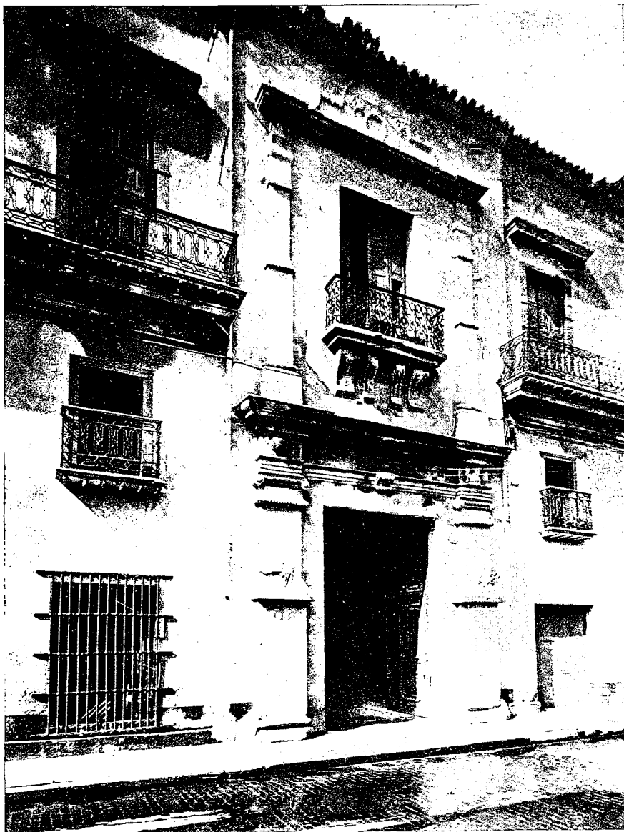
F ACHADA por la calle Mercaderes. Palacio de los Marqueses de Arcos. Siglo XVIII.
