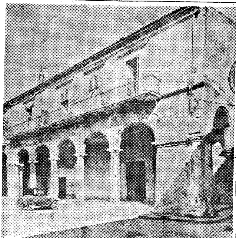
Fachada por la Plaza de la Catedral, Casa de los Marqueses de Arcos. (Siglo XVIII)
