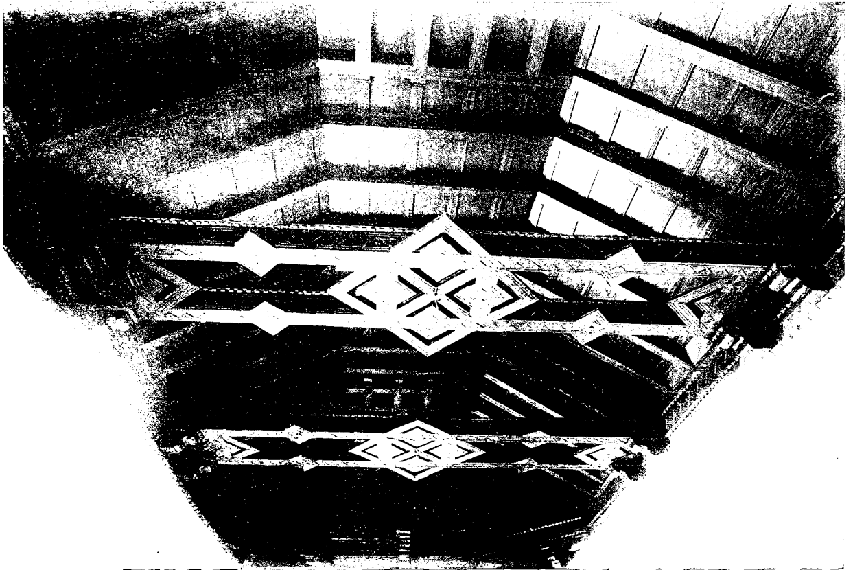
TECHO DE MADERA DEL SALON PRINCIPAL.
