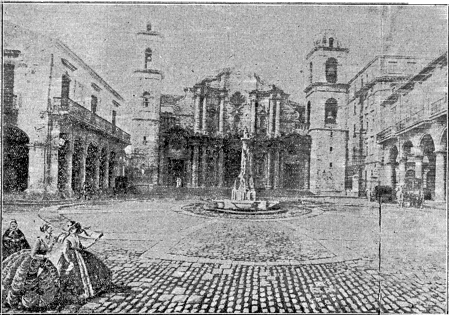
Vista del proyecto de restauración y embellecimiento de la Plaza de la Catedral por el arquitecto francés J. C. M. Forestier.—Al centro de la Plaza irá el lindo monumento que se yergue airoso en la Alameda de Paula. El piso actual será levantado para colocar adoquines grandes y chicos, formando las combinaciones que se ven en la fotografía. Los paramentos de los muros exteriores de las casas que rodean la Plaza serán restaurados también, raspando los de cantería y repellando y pintando de nuevo aquellos que están contruidos con otro material.—Esta Plaza debiera ser declarada monumento nacional y una vez expropiados los edificios establecer en ellos museos colonial de muebles; de libros y revistas; de estampas, litografías &, lográndose con ello una gran atracción para el turismo.
