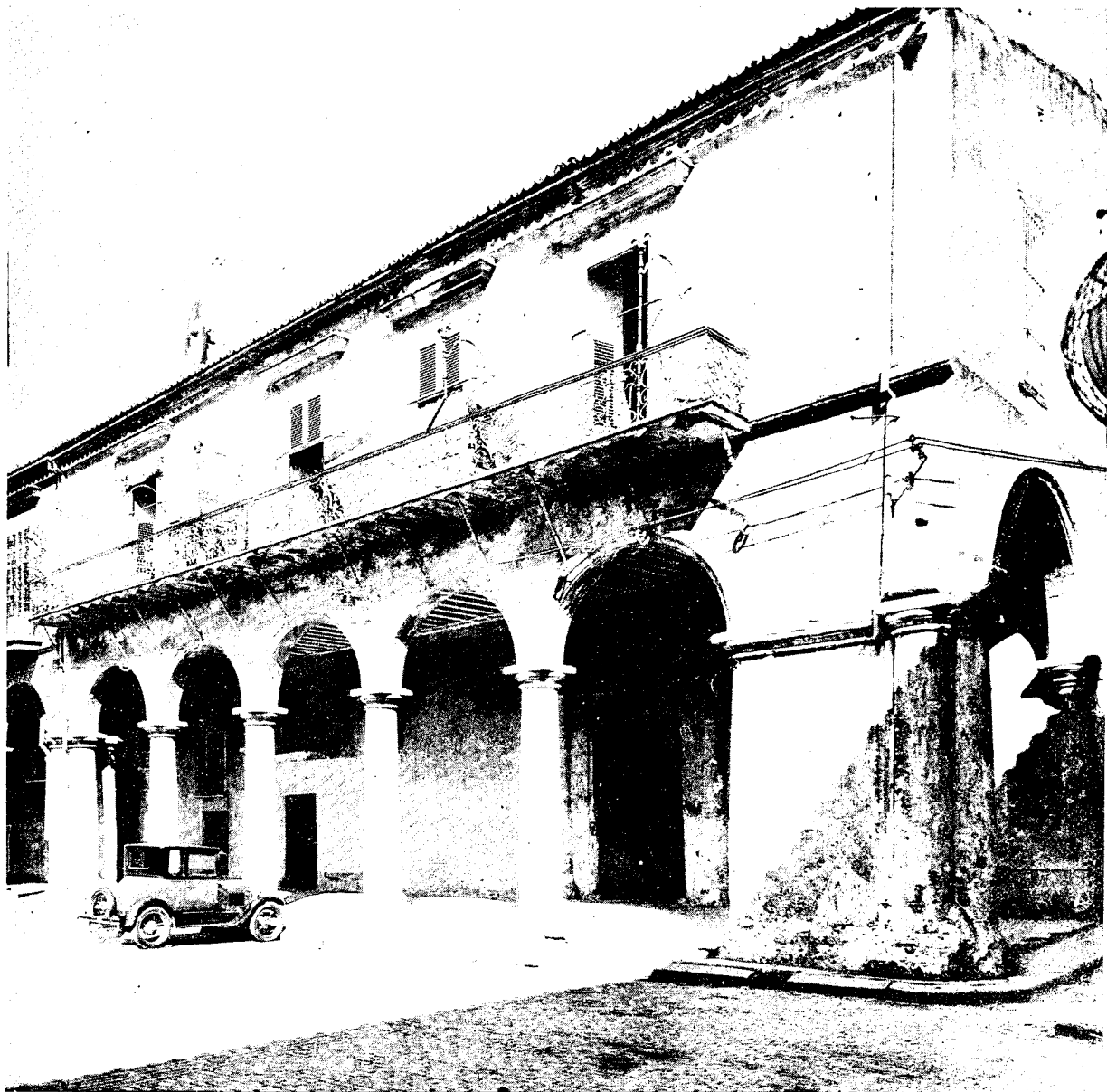
F ACHADA por la Plaza de la Catedral. Casa de los Marqueses de Arcos. Siglo XVIII.
