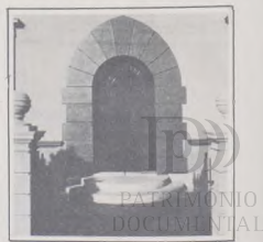
Detalle de la puerta principal
