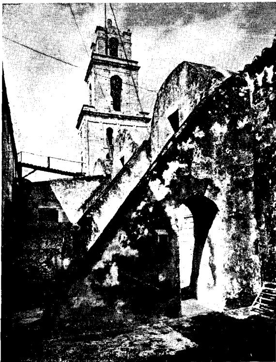
Un detalle de los contrafuertes de la azotea que sostienen el empuje de las bóvedas.
