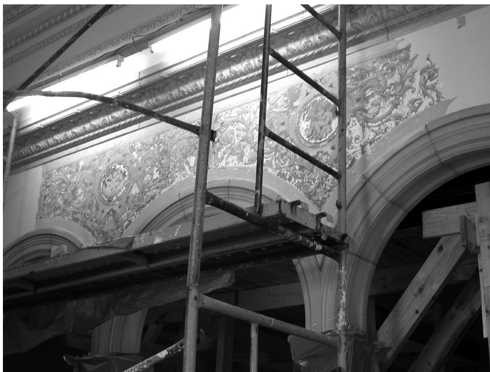
Fig. 4. Limpieza mecánica en proceso
