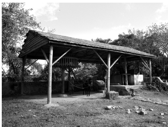
Fig. 2. La noria. Se puede observar la sustitución del techo por uno moderno de tejas francesas. Hacia el final de la estructura (a la derecha), se encuentra el depósito de agua y la tapa metálica (ca. 1950). Foto: Lisette Roura Álvarez
