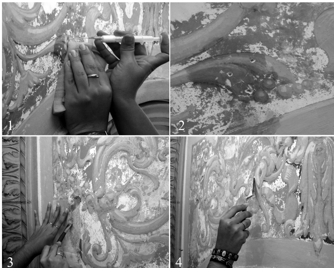
Fig. 7. 1 y 2. Consolidación por inyecciones de Ac33; 3. consolidación con papel japonés y carboximetil celulosa; 4. reintegro a base de estuco
