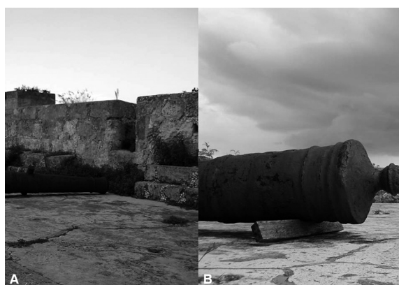
Fig. 4 A. Inexistencia total de acciones que eliminen las plantas oportunistas; estas corroen, degradan la piedra y amplían las grietas de separación entre los sillares. B. Pieza de artillería sin tratamiento anticorrosivo para evitar que los aerosoles marinos provoquen su corrosión y deterioro
