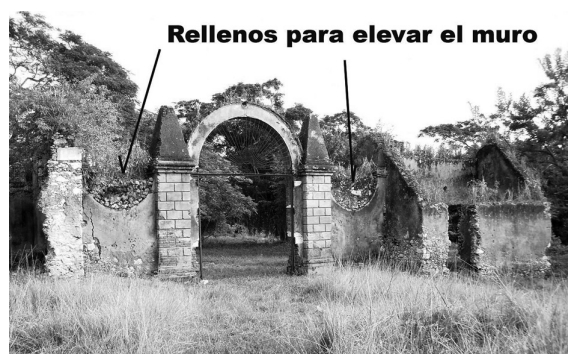
Fig. 5. Elevación del muro mediante el relleno de los arcos invertidos a ambos lados de la entrada
