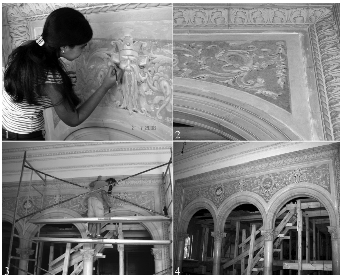
Fig. 9. 1 y 2. Reintegro de color; 3. capa de protección; 4. presentación final
