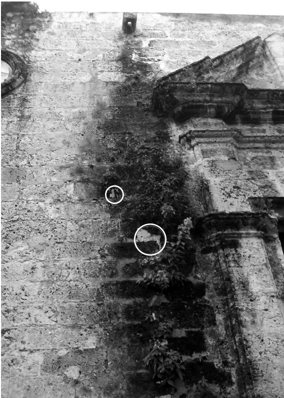
Fig. 2. El crecimiento de plantas favorece la acción mecánica de las raíces sobre los bloques o entre ellos, concentrando la humedad con la consiguiente descamación y desmoronamiento -en círculos blancos- de la superficie de las paredes en la Catedral de La Habana (foto de los autores)
