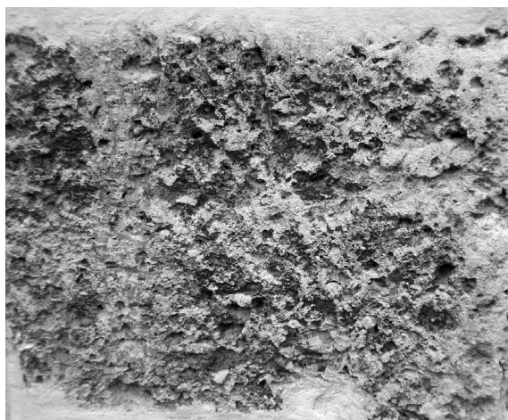
Fig. 3. La acción de los aerosoles marinos sobre bloques y sillares provoca el desmoronamiento y la degradación de la superficie de en la casa del conde de Casa Bayona (foto de los autores)
