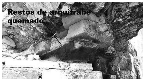
Fig. 9. Testimonio de un arquitrabe sometido a intenso fuego
