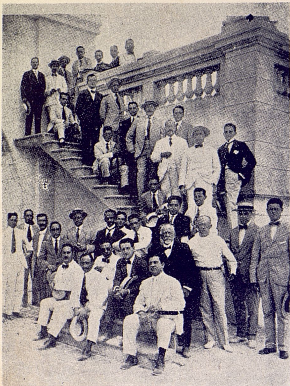
Los arquitectos visitan las obras que se ejecutaban para la construcción del actual Palacio Presidencial.
